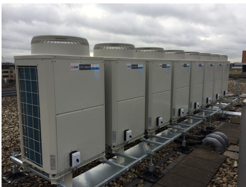
Figuur 1: Buitenunits van een VRF-systeem
