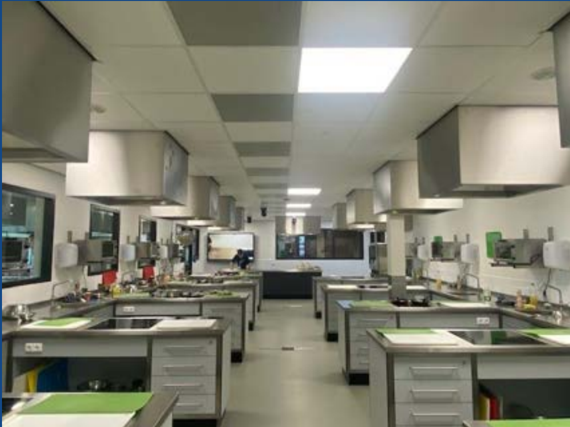
Figuur 2 Gerealiseerd: luchtkanalen stelsel geleverd en gemonteerd inclusief 12 afzuigkappen
