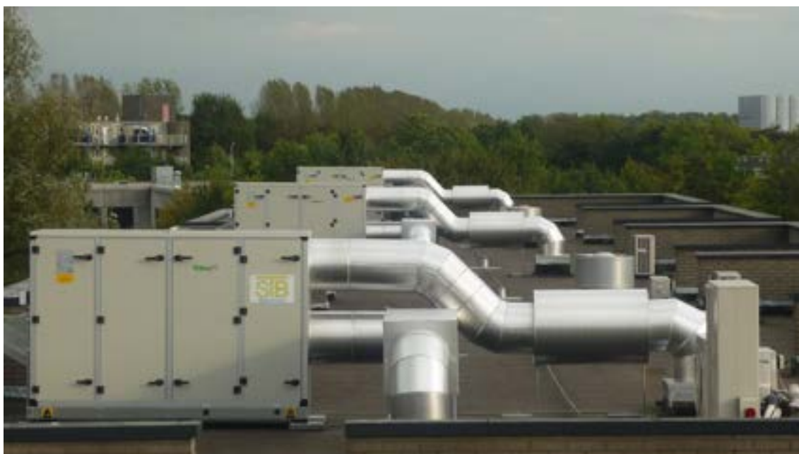
Figuur 10: Ventilatie met warmteterugwin(WTW)-units
