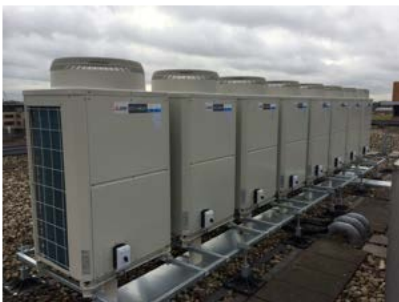
Figuur 1: Buitenunits van een VRF-systeem
